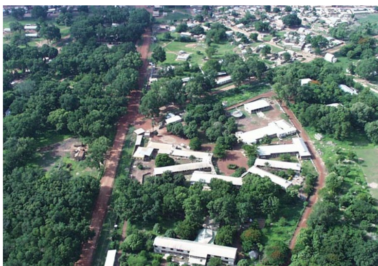
Veduta aerea dell'Ospedale di Tanguiéta
